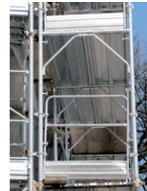
Ponteggio a telaio prefabbricato
